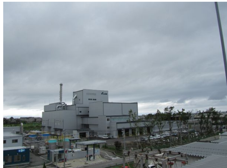
エネルギーセンター設置後
