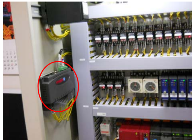
パルスを積算 盤左PCにて発電量集計(電力量①)
