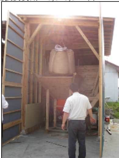
写真 1 ペレットボイラー建屋 (製材乾燥用 30kW)
